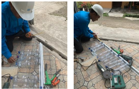
Gambar 2.2 Proses menyusun dan memasang botol plastik Pada Rangkaian reng baja ringan (Dokumentasi Pribadi, 2022)
